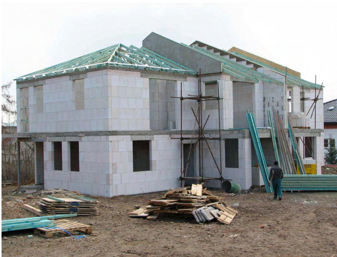
Stavby z KS-QUADRO jsou rychlé, čisté, přesné. Zde Benice u Prahy – firma Agrostav Jihlava a.s., foto Ing. Martin Konečný.
